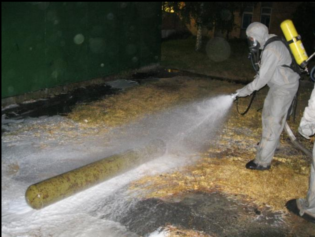
Устранение последствий повреждения баллона с хлором
